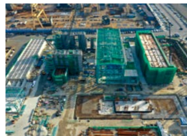
▲ LNG Power Plant Construction Site
